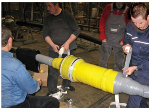
Фото: Монтаж соединительной муфты. Открытое распределительное устройство
